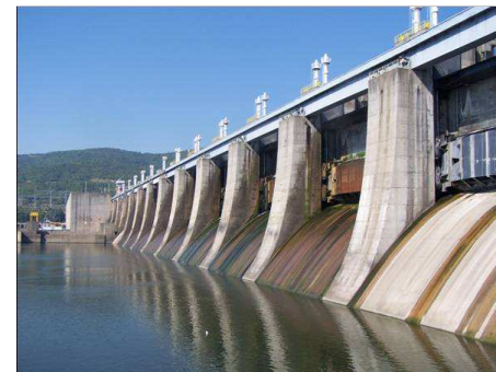
Hidrocentrala Portile de Fier 1
